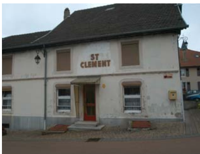
Anciens restaurants depuis désaffectés
